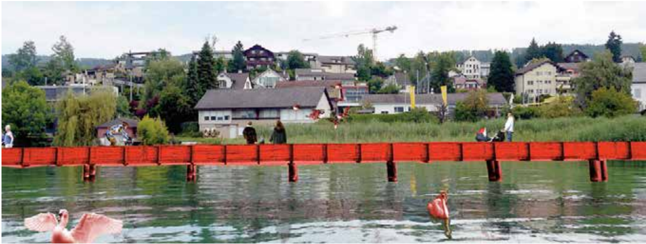
Beispiel einer Steglösung: nachher
