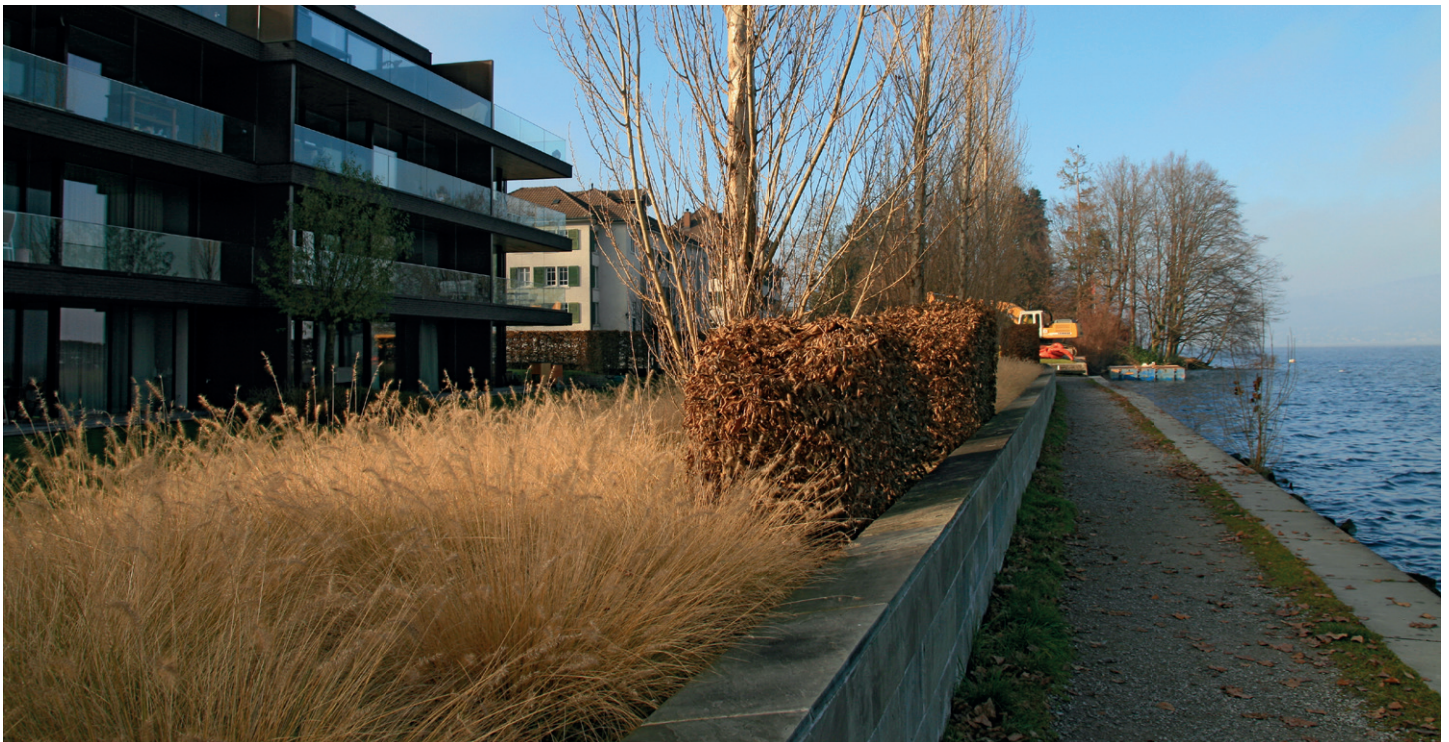
Seeuferweg vor neu erstellten Wohnungen, eröffnet 2013
